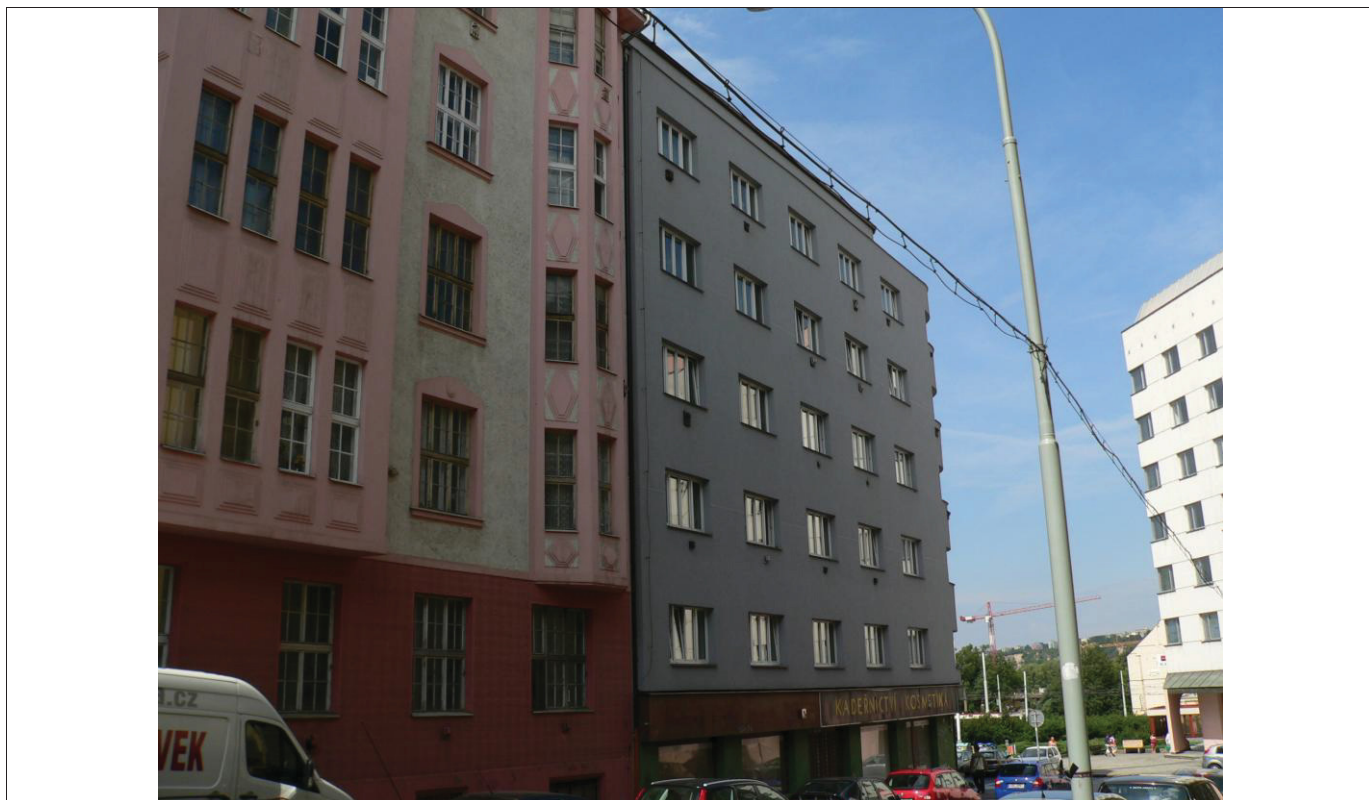
Celkový pohled na fasádu do ulice Palmovka.
