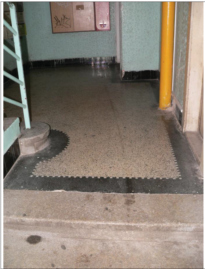
Detail vstupních prostor domu s litým terazzem.
