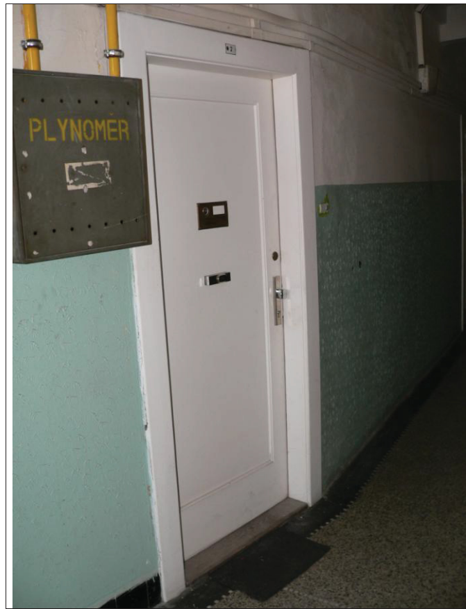
Detail vstupních dveří do bytu.
