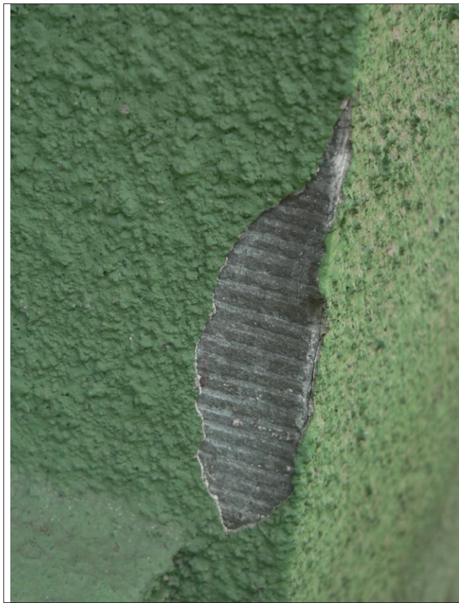
Detail fasády parteru z ulice Palmovka s původním provedením omítky.
