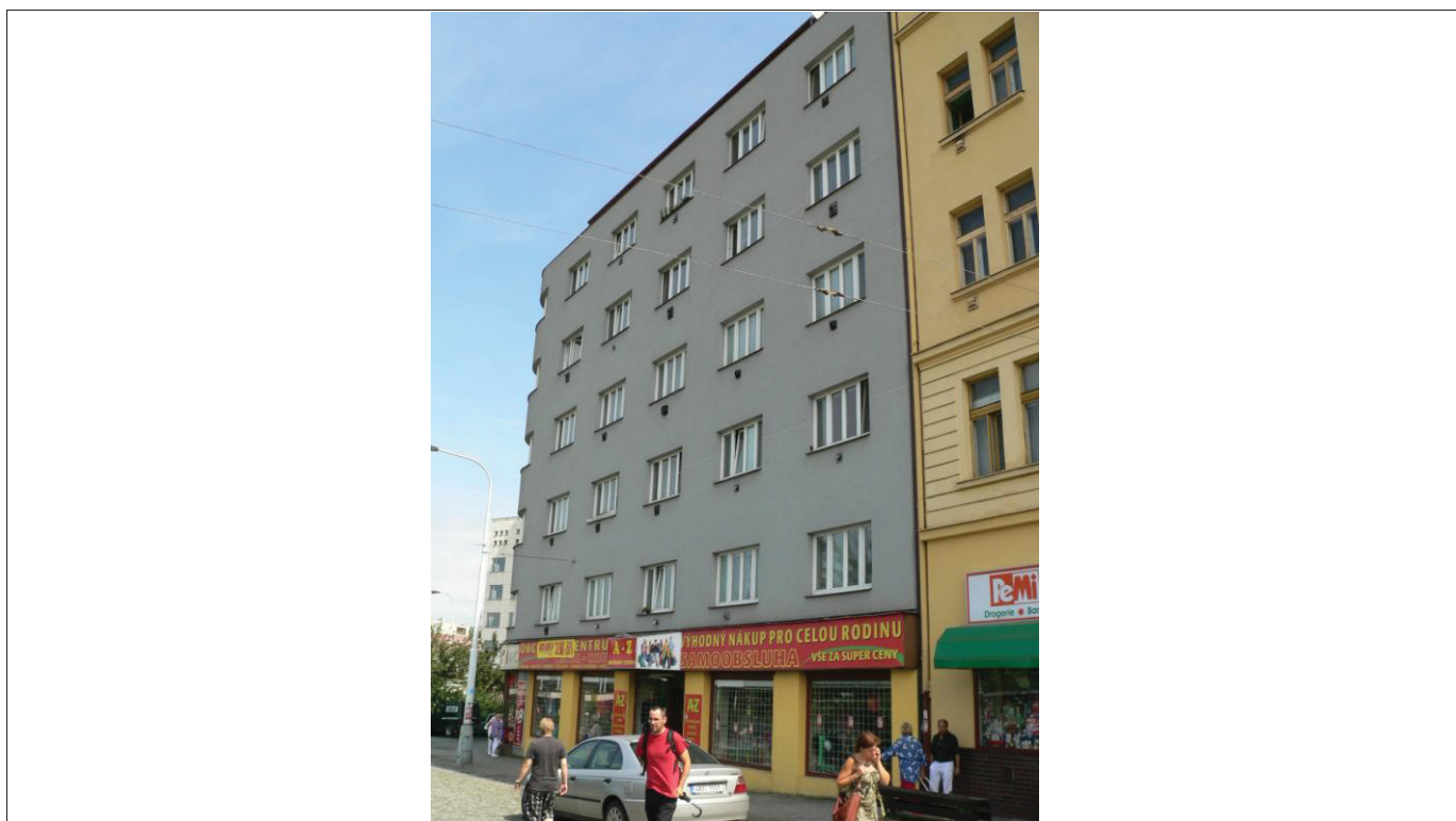
Pohled na fasádu, ulice Zenklova.
