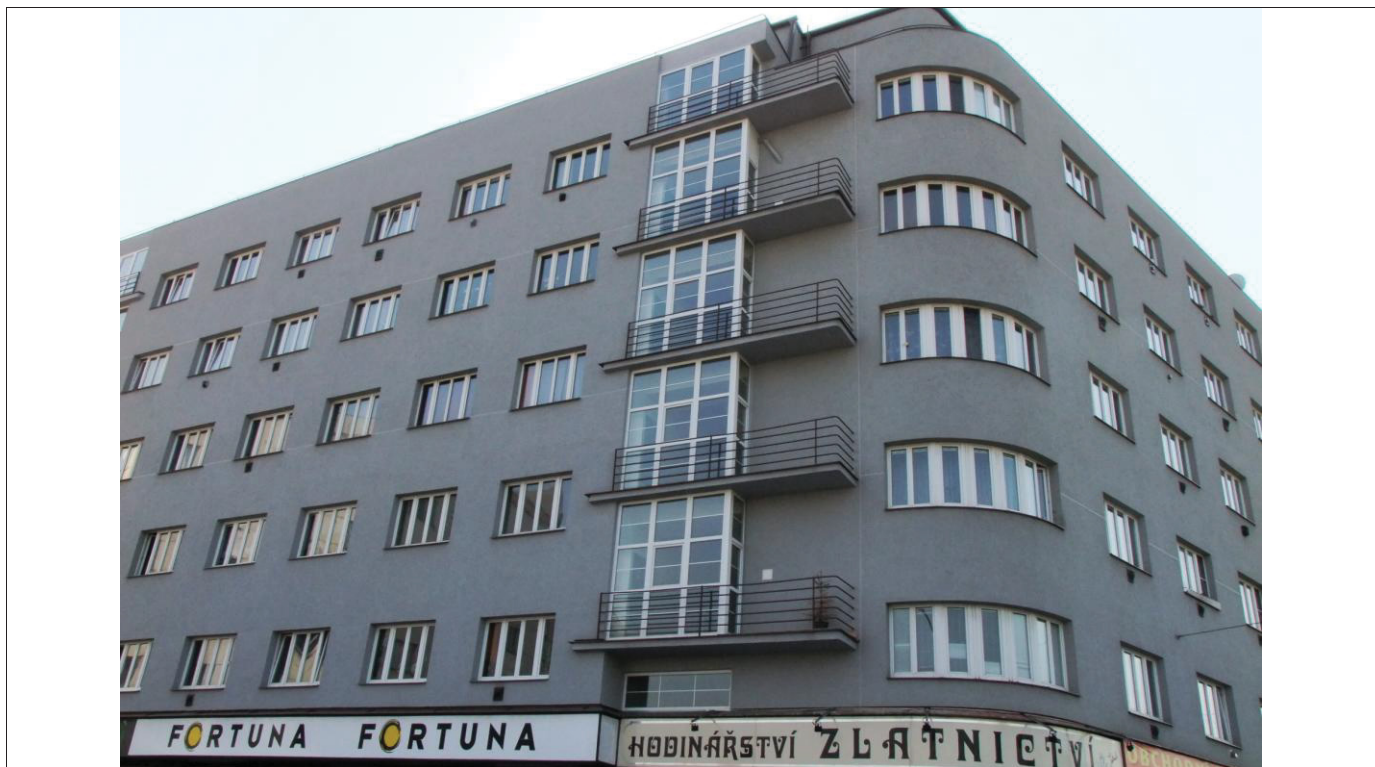
Pohled na fasádu z ulice Novákových s nárožím do ulice Zenklova.
